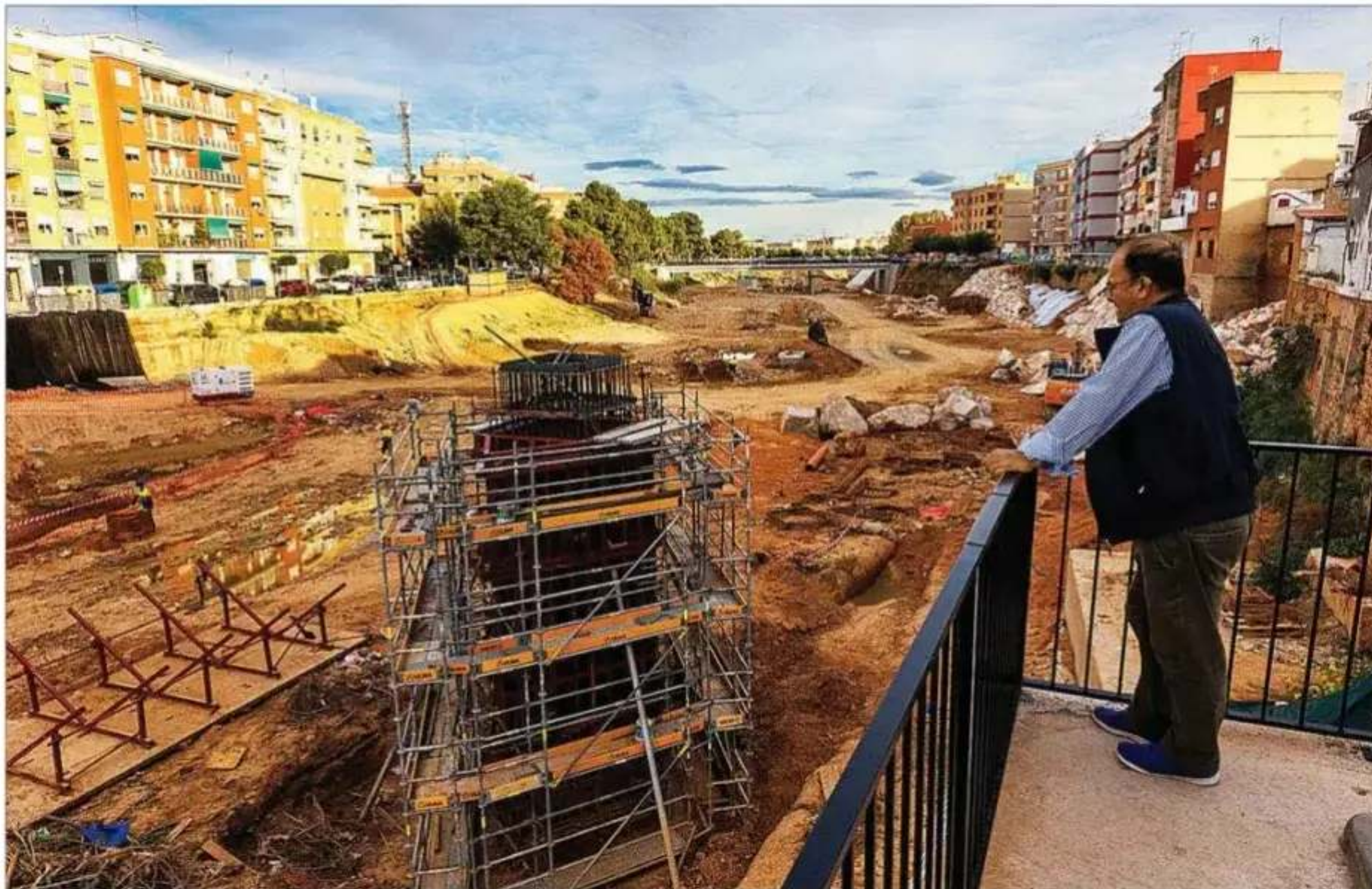
Un hombre observa las obras de reconstrucción en el barranco de El Poyo a su paso por la localidad valenciana de Paiporta.
